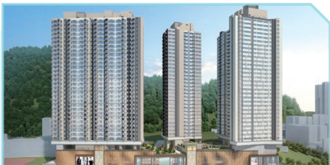
▼ Pak Wo Road project 粉嶺百和路項目
