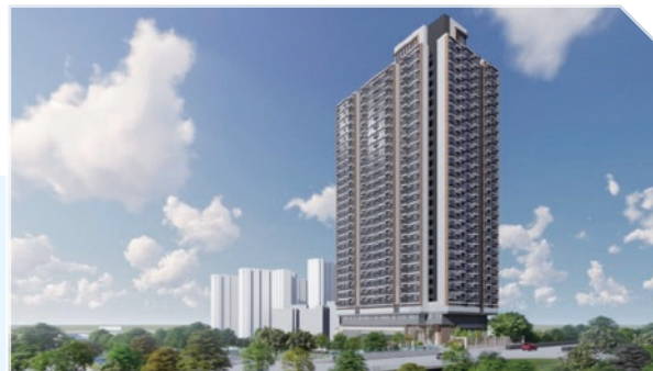
▲ Hung Shui Kiu Phase 1A project 洪水橋第 1A 項目
